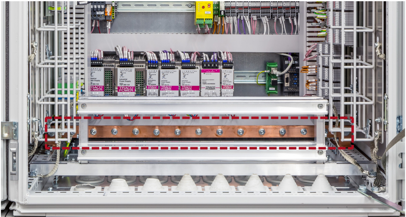
Figure 16: Earth rail in the AMB control cabinet
